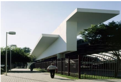
• نظام إنشائي خرساني تغطية لأماكن انتظار الركاب من موقف دا لوبا - البرازيل Terminal da Lapa
